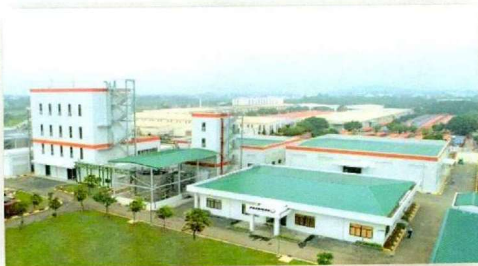
Hình 10: Hình ảnh nhà máy sản xuất Hóa chất tại Tập đoàn Phenikaa được đầu tư từ việc chuyển giao sáng chế số VN 25362
